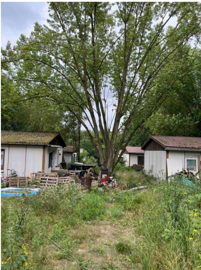
Eschenahorn im Bereich der baufälligen Bungalows
